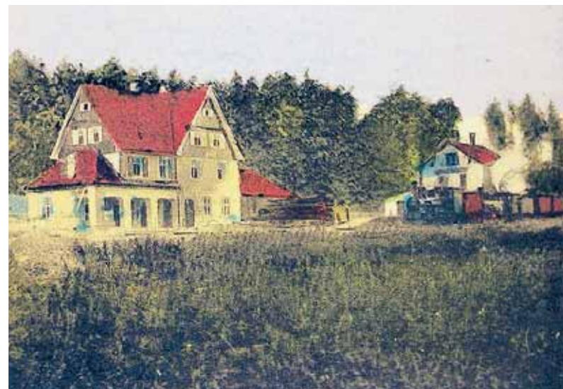
Die Postkarte um 1911 zeigt das neue Bahnhofsgebäude in Durlesbach. Der alte Bahnhof ist noch nicht abgebrochen. FOTO: STADTARCHIV BAD WALDSEE
